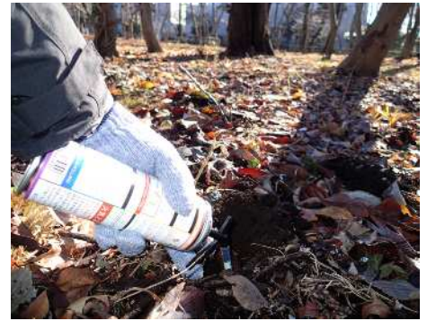
トンネルの途中から発泡ウレタンを注入
